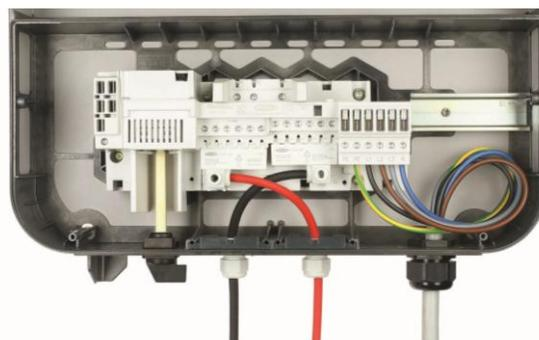
/ El conector Kit CC posibilita la conexión de las dos entradas de corriente MPP superior a 35 A y una sección de cable de más de 16 mm<sup>2</sup>, por ejemplo, al utilizar un DC Box. Con el conector Kit CC, se puede conectar una sección transversal de 6 mm<sup>2</sup> hasta 25 mm<sup>2</sup>. El terminal está diseñado a prueba de golpes sin necesidad de férulas protectoras. El conector Kit CC es perfecto para su uso con los inversores Fronius Symo 10.0 - 20.0 kW y Fronius Eco.
